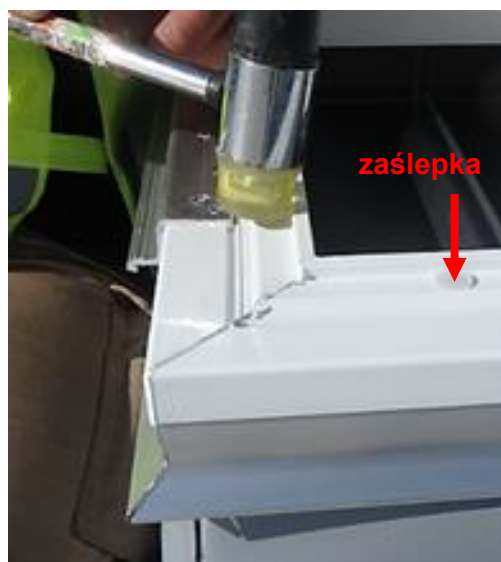
Rys. 36. Montaż zaślepek w wieńcu PVC.
