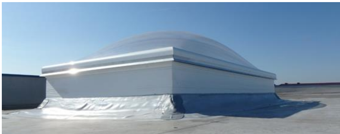
Rys. 19. Świetlik / klapa / wyłaz mcr ULTRA THERM po skończonym montażu.
