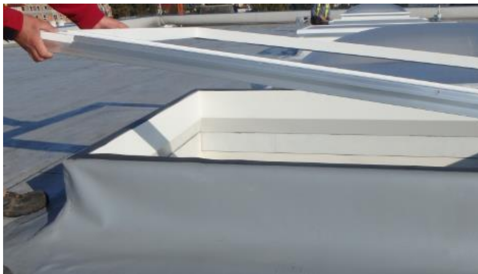
Rys. 34. Układanie wieńca PVC na uszczelce PES.
