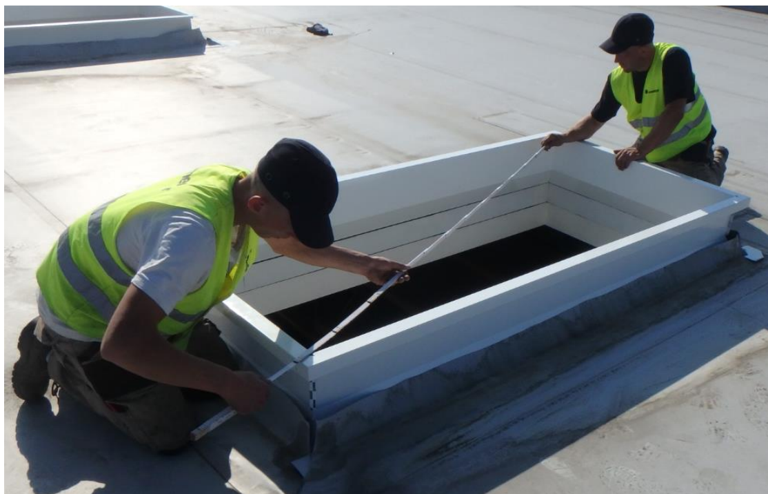
Rys. 29. Sprawdzanie przekątnych.
