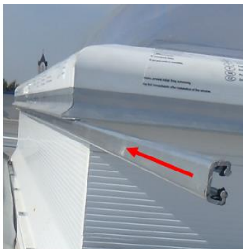
Rys. 41. Nasuwanie łącznika.
