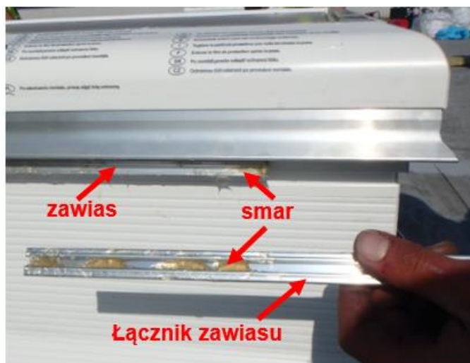
Rys. 40. Smarowanie zawiasu.
