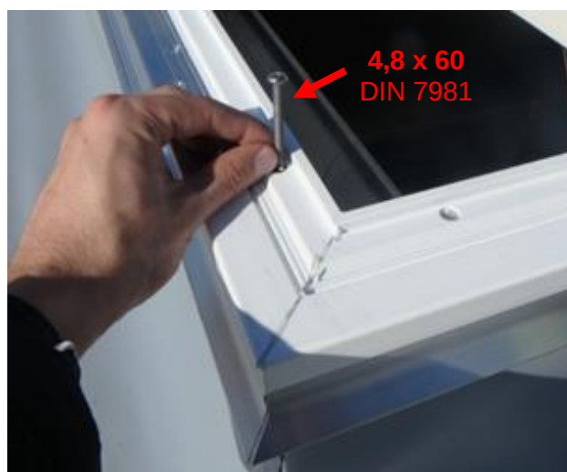
Rys. 35. Przykręcanie wieńca PCA do podstawy metalowej.
